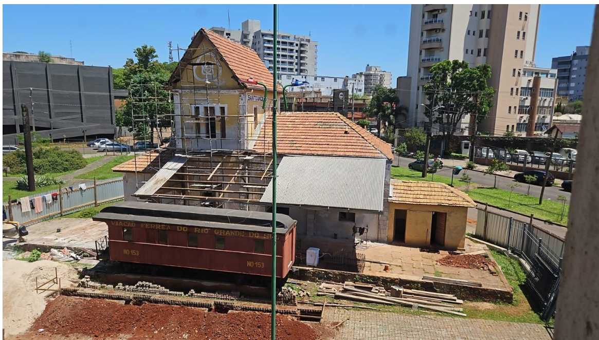
Obras de restauro no Memorial Coluna Prestes. Fonte: Valter Portalete, 2025.
