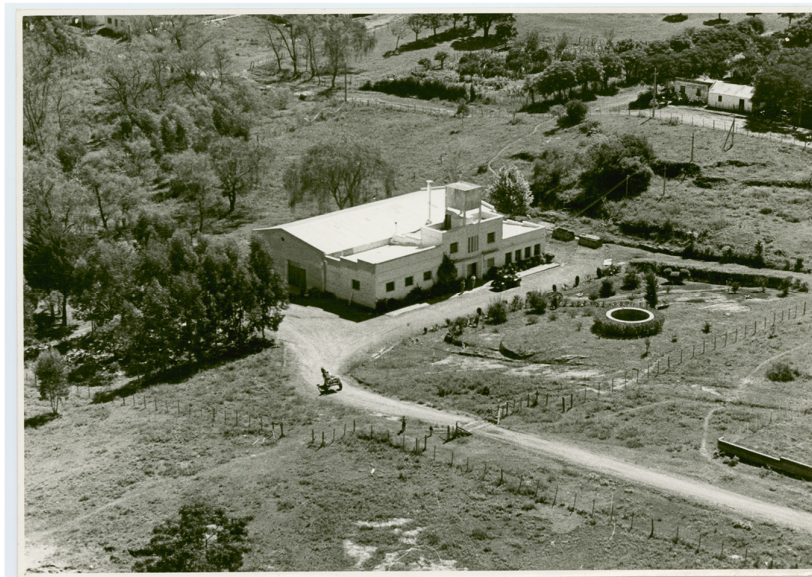
Planta Industrial ubicada en calle 12 de Octubre y Misiones. Fuente: Biblioteca Nacional
