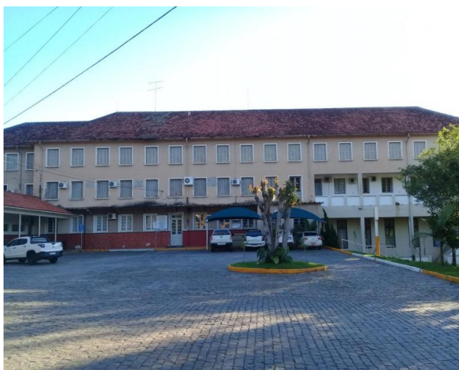
Figura 5: Prédio principal do Pré-Seminário São José em Faxinal do Soturno. Fonte: Fotografia digital do acervo de Vanessa Baccin (2021).
